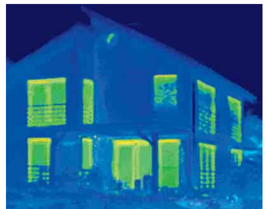
Efter den omhyggelige montering af nye vinduer af profilsystemet Schüco Alu Inside beviser termografien det høje energiudbytte af investeringen.
