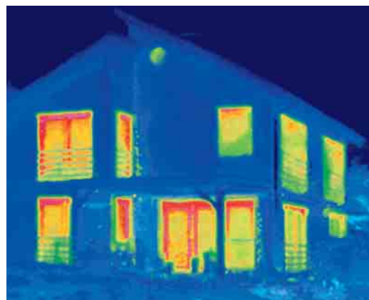
Infrarødoptagelser – Termografier – viser tydeligt, hvor et hus ukontrolleret taber energi. Rød betyder varme – og dermed højt energitab.
